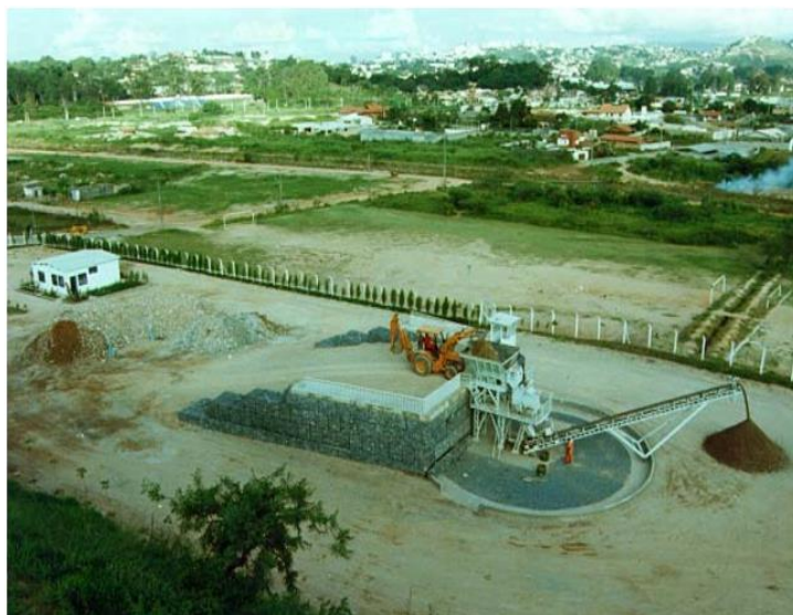
Figura 11 – Usina de RCD Pampulha (Belo Horizonte).
