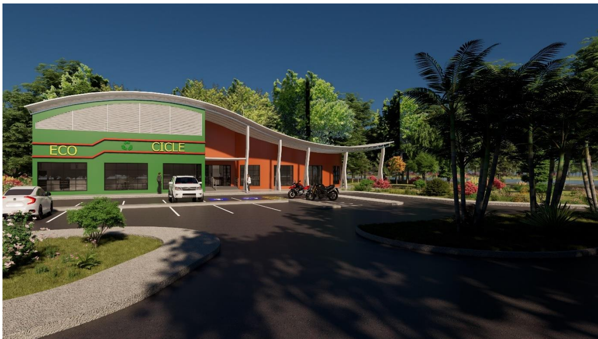
Figura 40 – Fachada do Prédio administrativo
