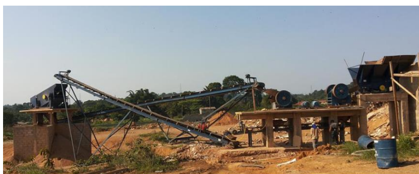
Figura 31 – Conjunto de britagem da Processadora de resíduos Sólidos de Porto Velho/ RO.
