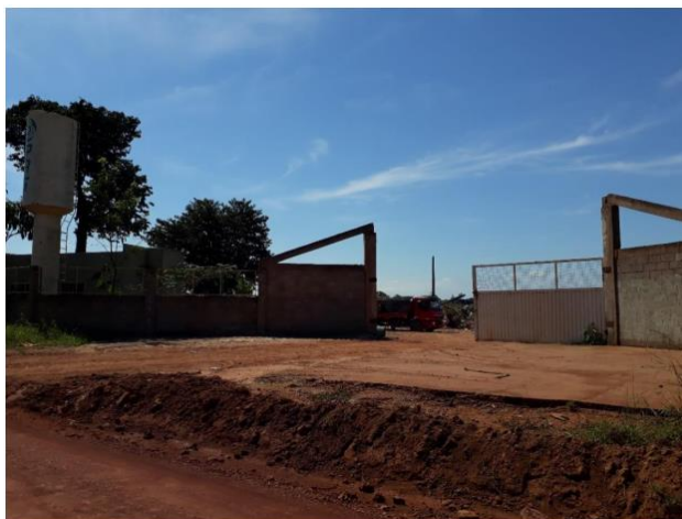
Figura 17 – Processadora de resíduos Sólidos de Porto Velho/ RO.
