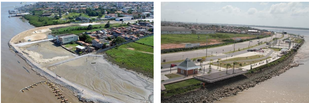
Figuras 39 e 40: Execução do aterro hidráulico do projeto Portal da Amazônia e a obra executada, ao sul de Belém. Fonte: Prefeitura Municipal de Belém, s.d.
