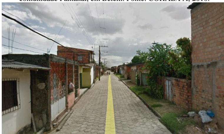
Figura 46: Via não asfaltada da comunidade Pantanal. Fonte: Google Street View, 2019.
