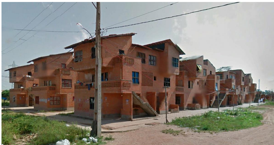
Figura 35: Residencial Liberdade. Fonte: Google Street View, 2019.
