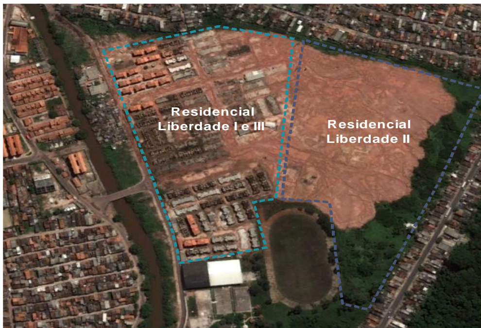
Figura 36: Áreas de implantação do Residencial Liberdade I, II e III.
