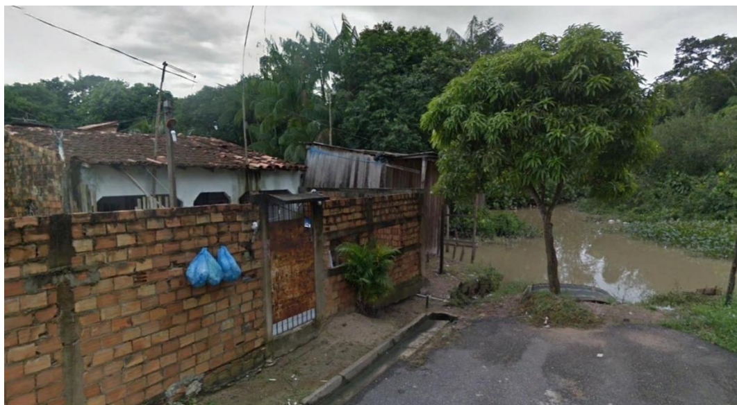
Figura 61: Margem do rio Paracuri, em Icoaraci. Verifica-se a presença de uma palafita e uma casa de alvenaria. Fonte: Google Street View, 2019.
