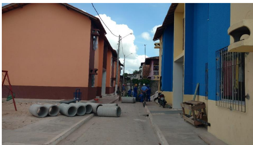
Figura 51: Unidades habitacionais do PAC Taboquinha. Fonte: RODRIGUES, 2017.
