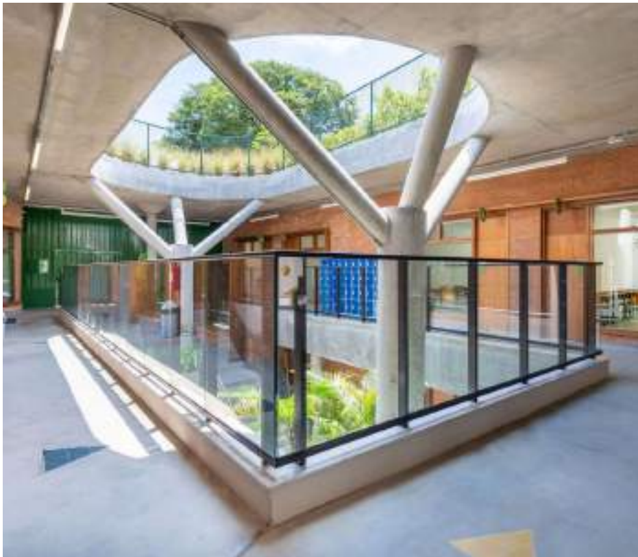
Fotografia 14 – Pilar-árvore na Escola CAMB
