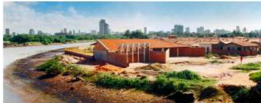
Fotografia 26 – Escola Novo Mangue durante as obras
