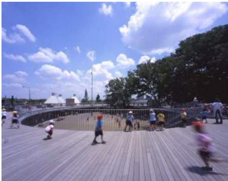
Fotografia 28 – Cobertura deck da Escola Fuji Kindergarten
