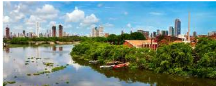
Fotografia 27 – Escola Novo Mangue após a conclusão das obras
