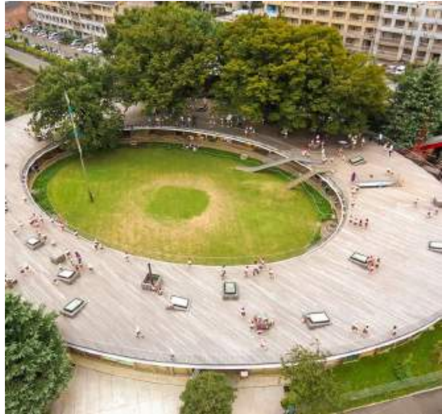
Fotografia 33 – Vista superior do jardim da Escola Fuji Kindergarten
