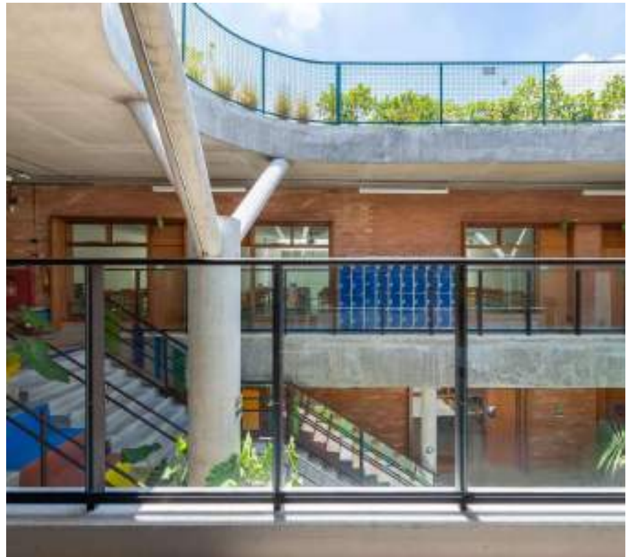
Fotografia 15 – Pilar, materiais e cantos arredondados na Escola CAMB
