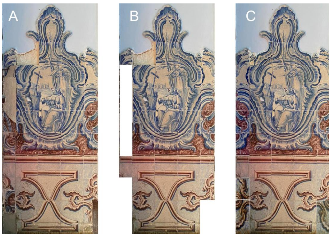
Imagem 95 - Painel “Frade leitor” atualmente (A); Azulejos identificados como equívocos (B); Painel reconstituído após edição no PhotoShop (C). Foto, Retificação e Edição Autorais.
