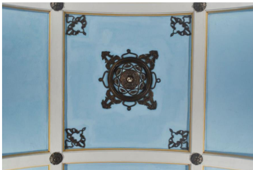
Imagem 22 - Detalhes do forro. Foto: Bruna Danielle Pantoja (2023).
