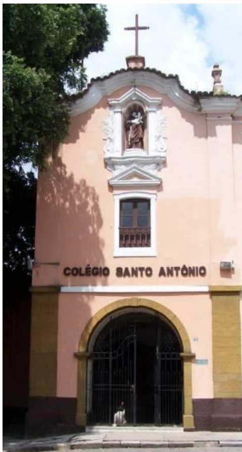
Imagem 07 - Fachada do Convento de Santo Antônio, voltada para a Tv. Frei Gil de Vila Nova. Fonte: Alencar (2019).
