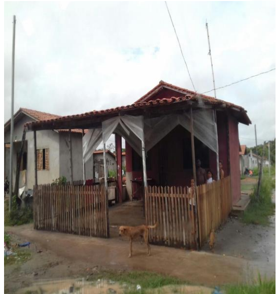
FOTO 05: Casa já modificada
