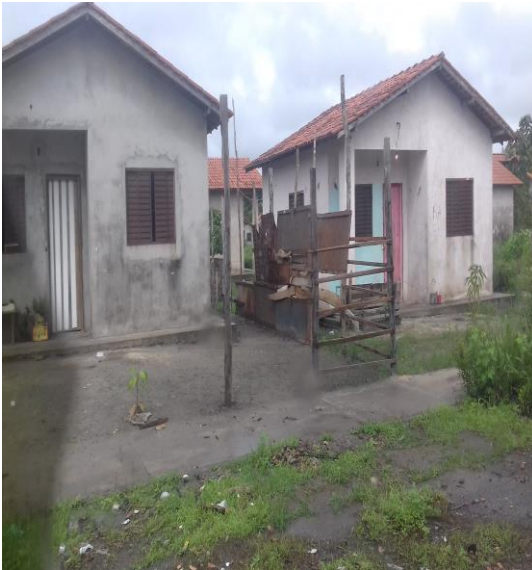
FOTO 04: Casa em ocupação irregular
