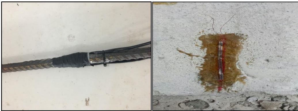
Figura 3.15 - Extensômetros executados e fixados.
