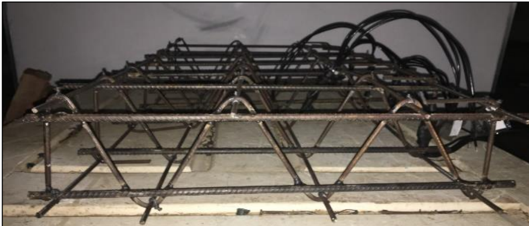
Figura 3.6 - Módulo de estribo W
