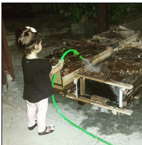
Figura 3.29 - Cura do concreto
