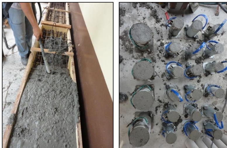
Figura 3.28 Adensamento do concreto e moldagem dos corpos de prova.
