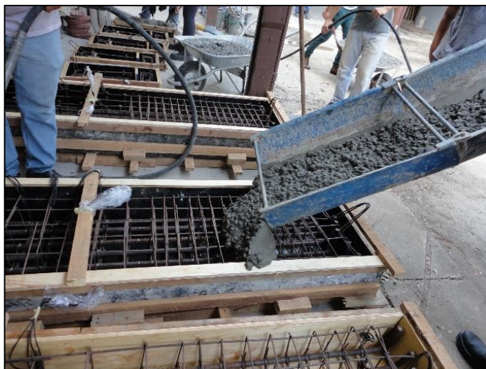
Figura 3.27 - Lançamento do concreto
