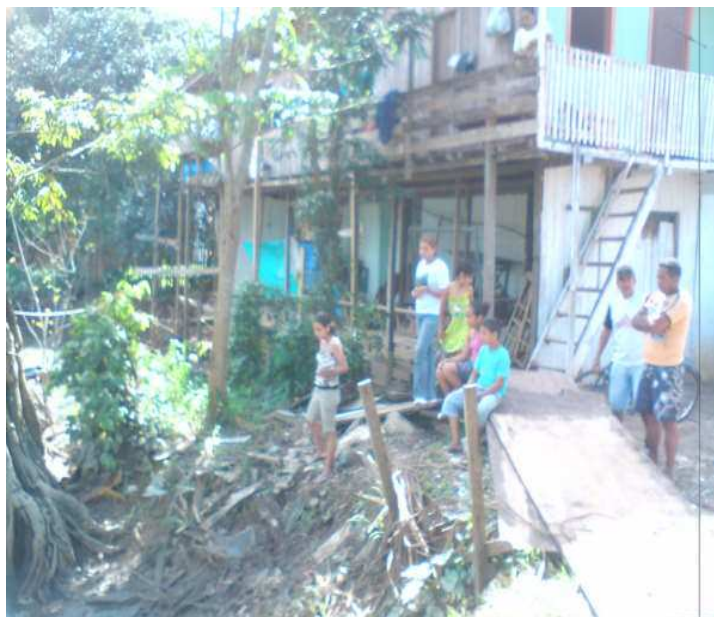
Figura 11 - Casas construídas com madeira retirada das matas ciliares.
