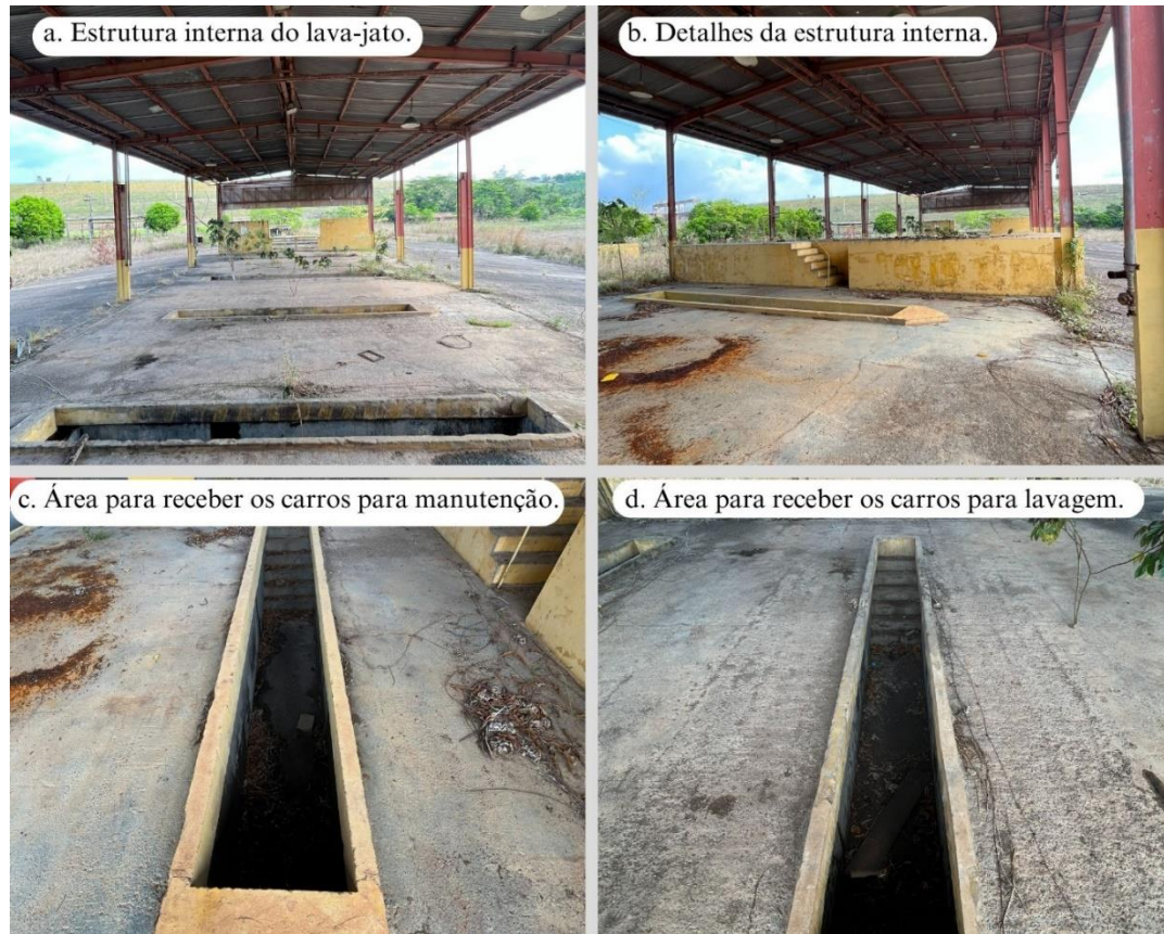
Figura 3. Estrutura existente Lavatec.
