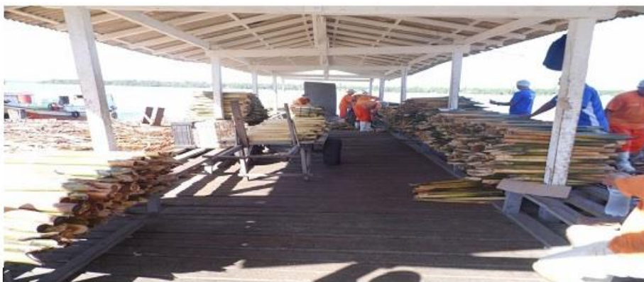
Figura 6: Ponte de recebimento de matéria prima e armazenagem.
