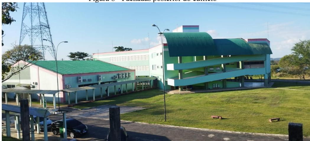
Figura 8 - Fachadas posterior do edifício
