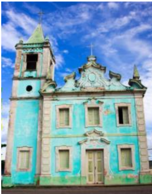
Imagem 2 - Fachada da Igreja Matriz de São Domingos de Gusmão durante processo de pintura
