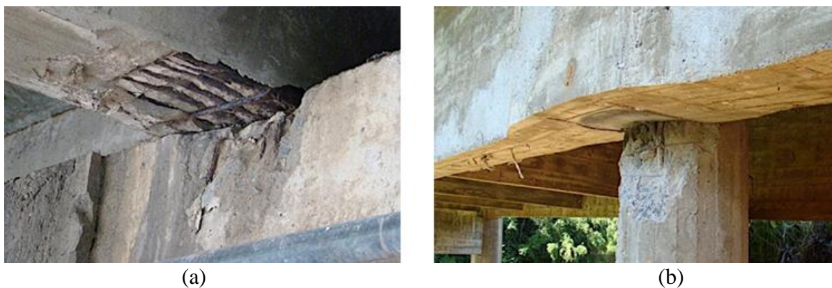
Figura 12 – Esmagamento do concreto
