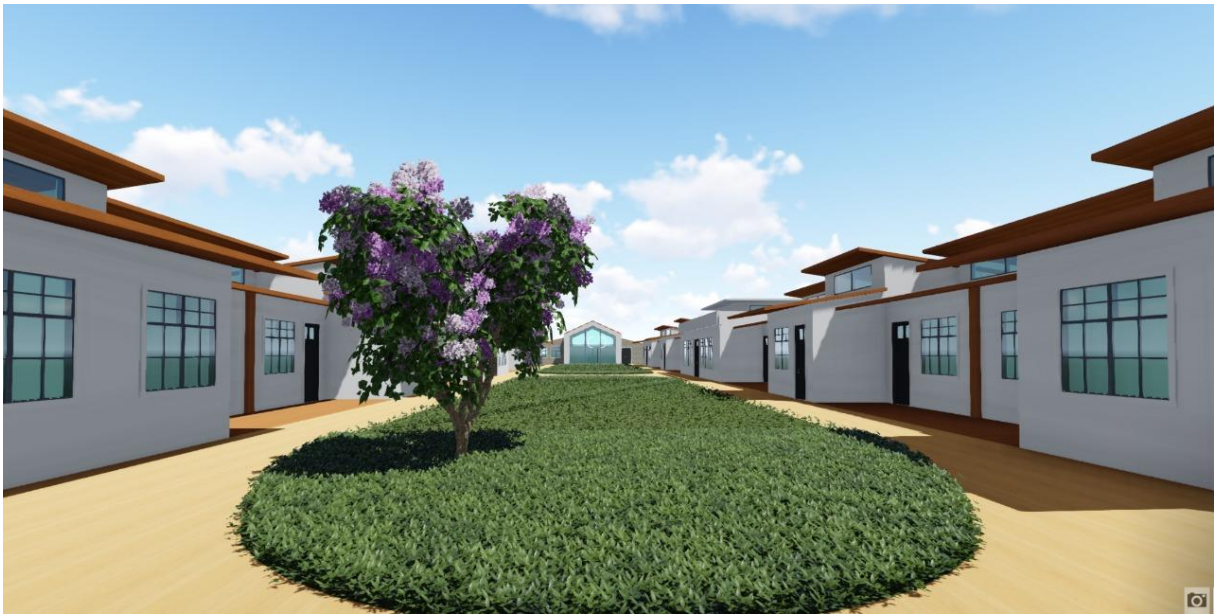
Figura 31: Vista Interior 01 do Hospice Fonte: Elaborado pela autora
