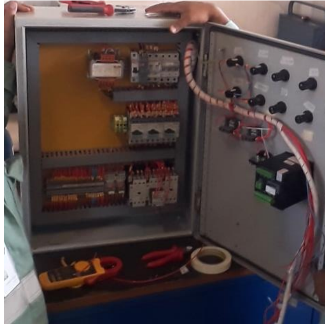
Figura 39 – Montagem e teste do painel em bancada
