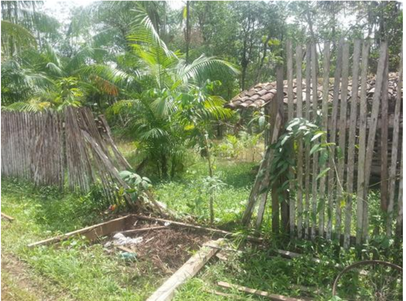
Figura 21 - Residências em área de planícies do Igarapé Moreninho, terreno alagadiço desfavorável à ocupação.
