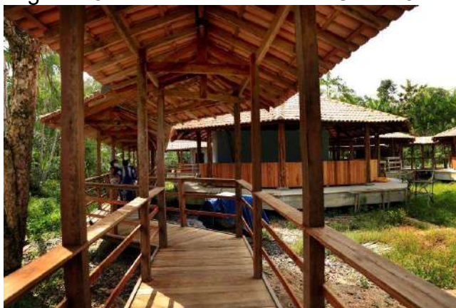
Figura 15 - Foto interna da EMEC São José.
