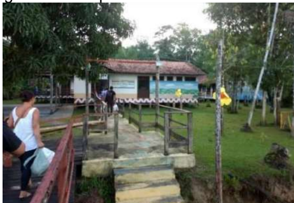
Figura 30 - Trapiche da escola Milton Monte
