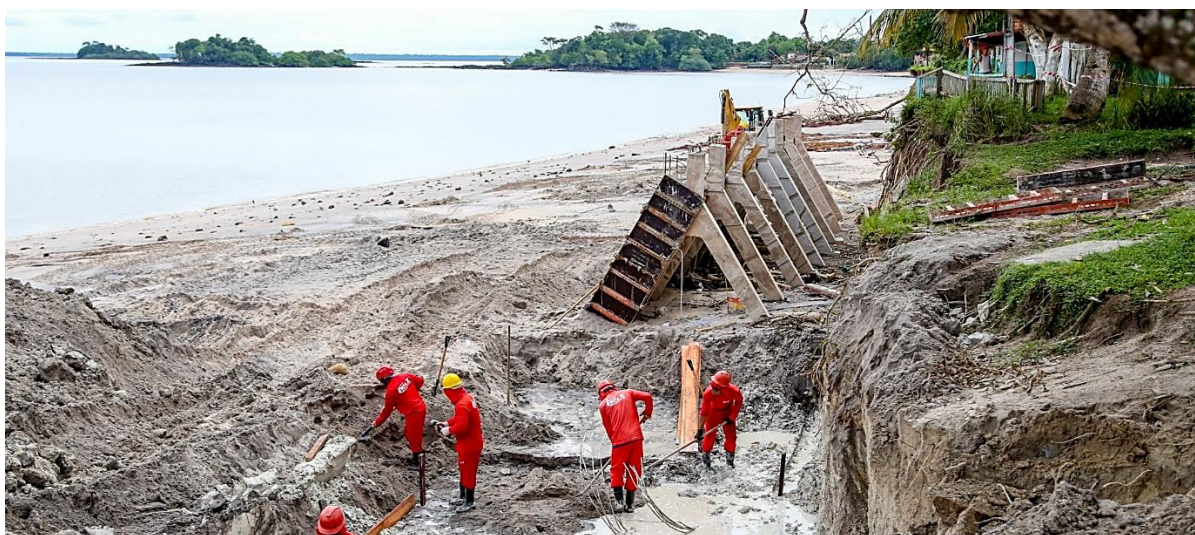
Figura 4.6 Obras de contenção da erosão na praia do Paraiso, Ilha de Mosqueiro. Foi previsto a construção de 600m de muros de arrimo para conter o desmoronamento das falésias baixas e consequentemente a destruição dos imóveis sobrejacentes. Obras similares ocorrem em outras nove praias ao longo da costa. Fonte: Agência Belém de Notícias (2019).
