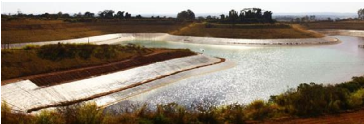
Figura 17- Barragem de Rejeitos.
