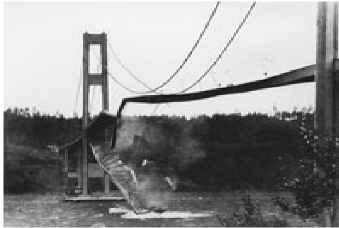
Figura 4: Colapso da ponte Tacoma Narrows
