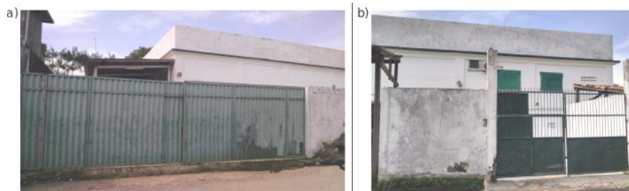
Figura 30 – a) portão de carga e descarga; b) portão de acesso de funcionários.
