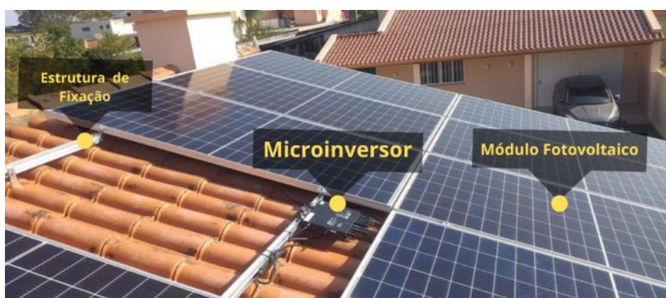
Figura 6 - Microinversor.
