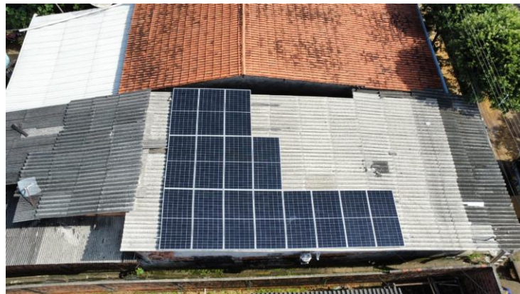
Figura 19 - Instalação com módulos monofaciais.
