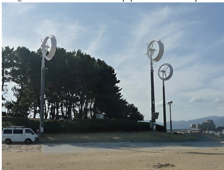
Figura 3 – Microturbinas eólicas equipadas difusores compactos.
