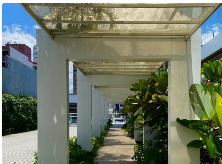
Figura 28 - Pavimento térreo, passarela de entrada
