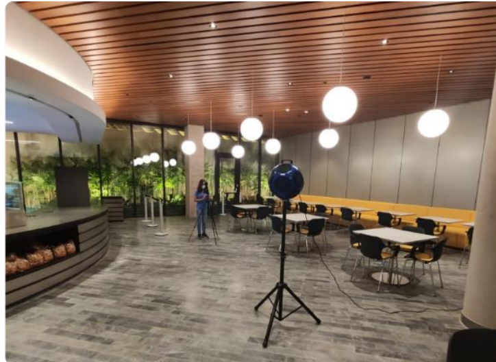
Figura 10 - Forro de madeira e lã mineral para controle de reverberação no refeitório do hospital Albert Einstein, em São Paulo.
