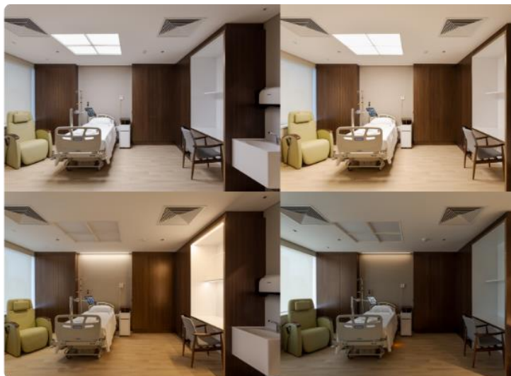
Figura 4 - Sistema de iluminação que simula a variação da luz do dia, Hospital Vila Nova Star, São Paulo.
