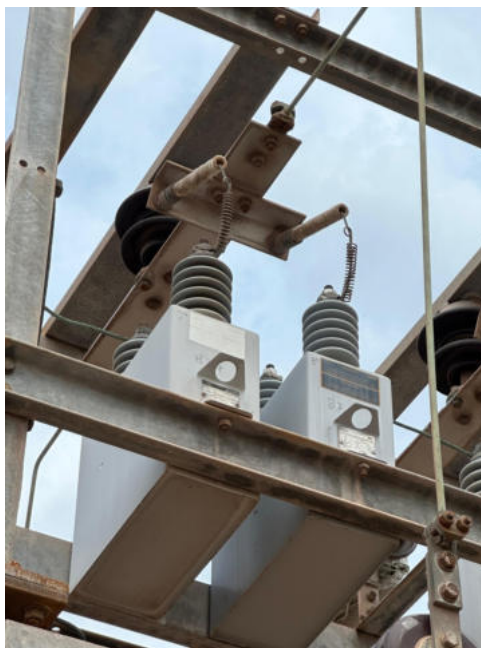
Figura 36 – Arranjo das células capacitivas em paralelo em uma das fases do estágio.
