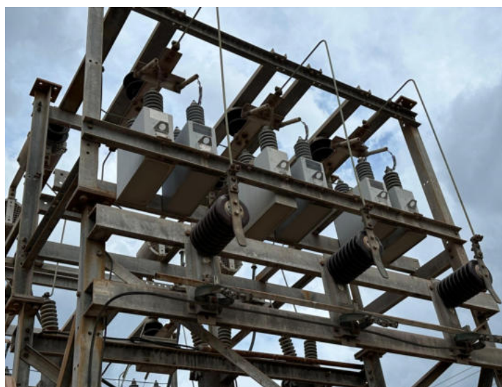
Figura 35 – Vista geral do conjunto trifásico correspondente a um estágio do Banco de Capacitores BCP-03.
