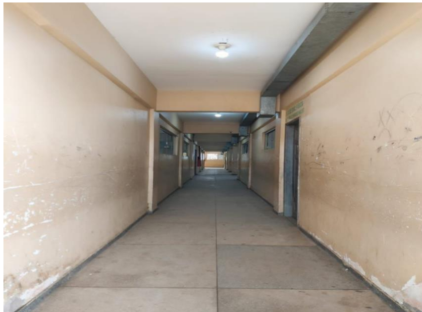
Figura 4 – estrutura interna da Escola.
