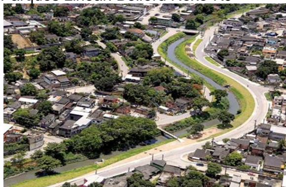
Figura 10 – Recuperação e urbanização das margens de trecho Rio Machambomba, com a instalação de Parques Linear. Belford Roxo-RJ
