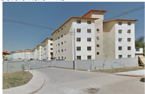
Figura 11 – Implantação do Residencial para receber as famílias dos remanejamentos do Rio Machambomba. Belford Roxo – RJ
