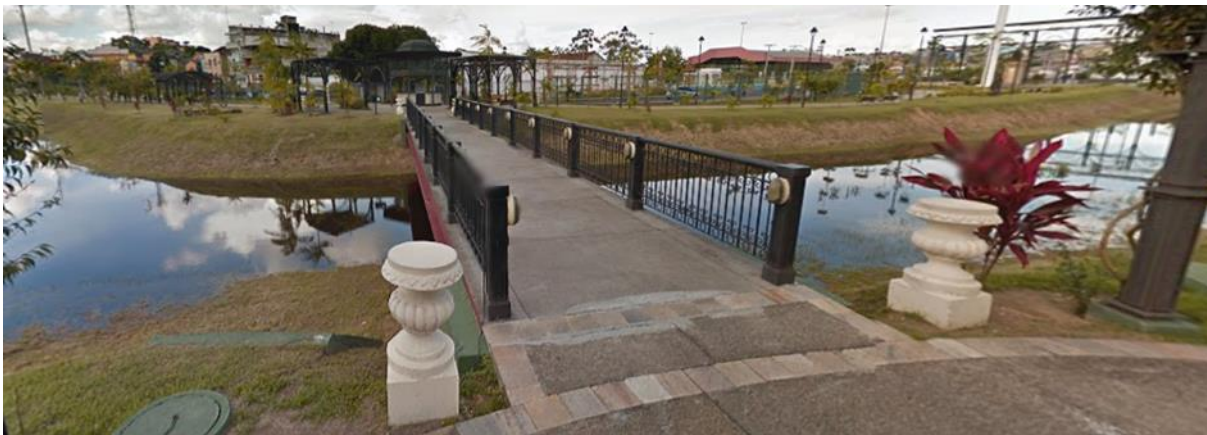
Figura 05 – Macrodrenagem e Parque linear fechado, intervenções feitas no Igarapé Manaus.
