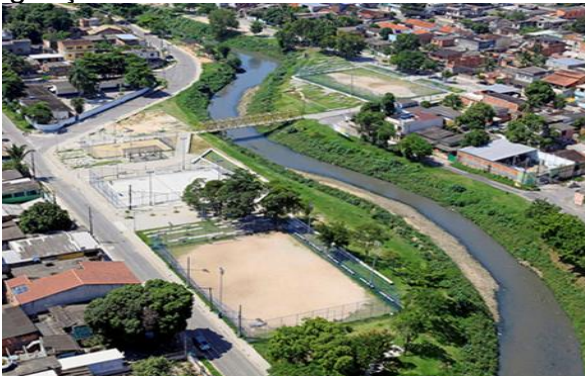
Figura 08 – Recuperação e urbanização das margens do Rio Botas, com a instalação de Parques inundáveis, Nova Iguaçu-RJ
