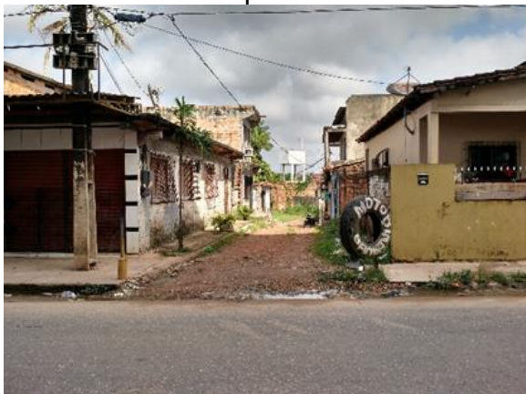
Figura 34 - Via local sem nome com conexão à rua Leopoldo Teixeira.
