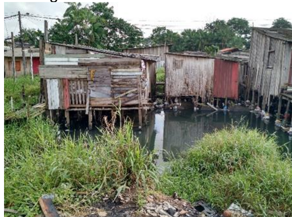
Figura 41 – Assentamento precário. Passagem Antena
