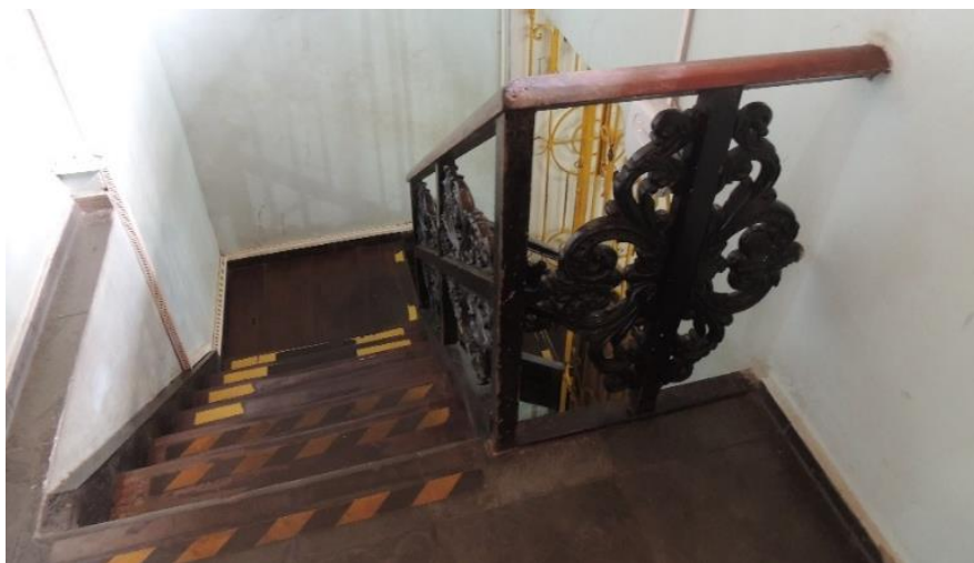
Figura 54: Escada resgatada do Palacete Bolonha
