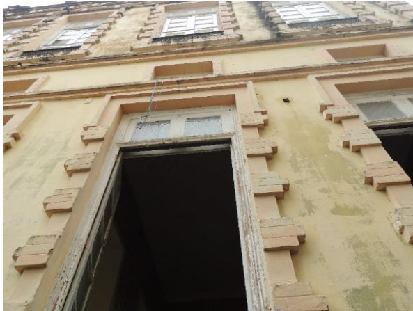
Figura 11: Janela de uma das casas da Vila Bolonha: revestimento em relevo com bossagem em massa.
