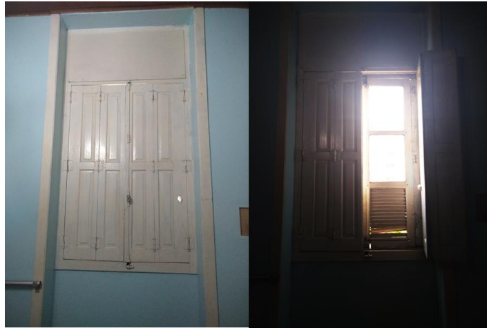
Figura 64: Exemplar de Janela da fachada posterior
