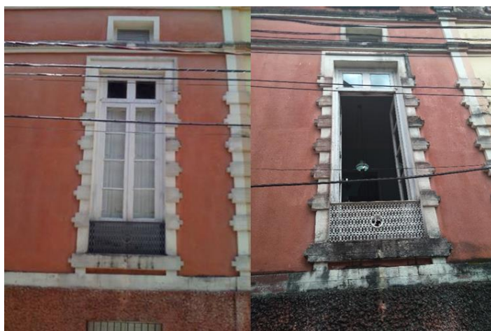
Figura 62: Exemplar de Janela da Fachada Principal – Parte Externa
