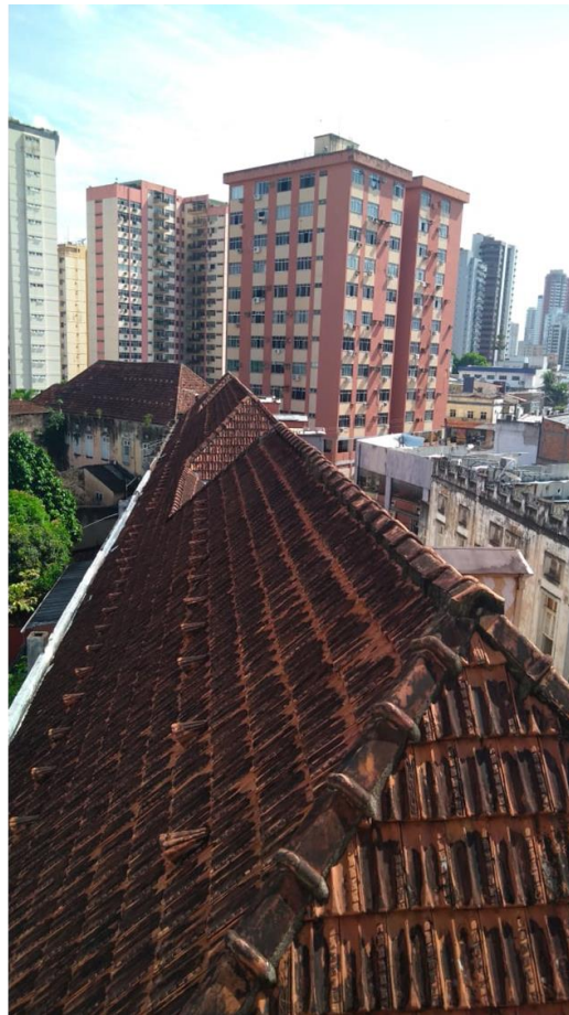
Figura 32: Cobertura/Telhados da Vila Bolonha – Vista do Palacete Bolonha
