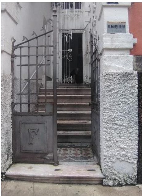
Figura 48: Portão do acesso Principal
