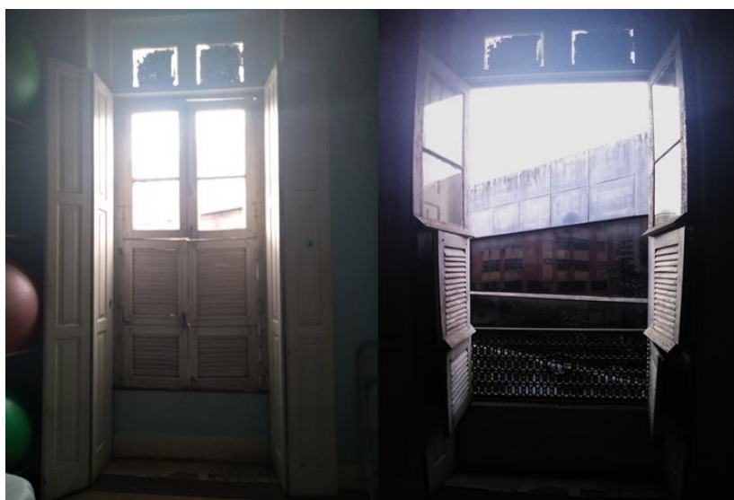
Figura 63: Exemplar de Janela da Fachada Principal – Parte Interna
