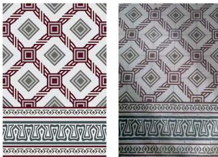
Figura 41: Composição de Ladrilhos Hidráulicos na Recepção (sala de visitas)
