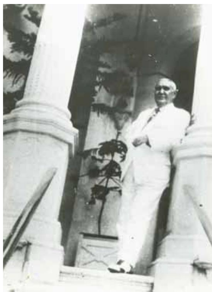
Figura 3: Francisco Bolonha no hall de acesso ao Palacete.
