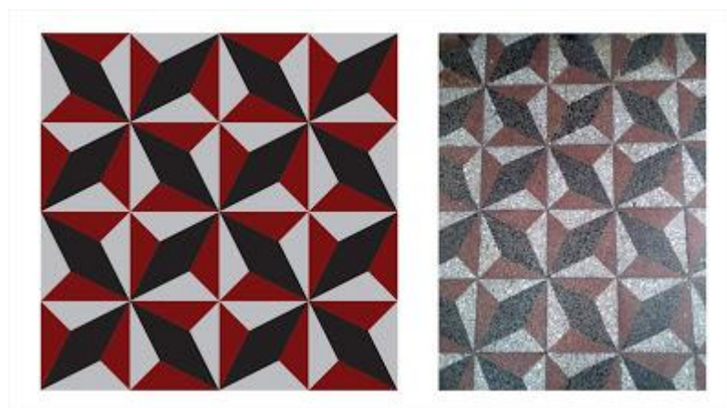
Figura 40: Composição de Ladrilhos Hidráulicos no hall da escada caracol
