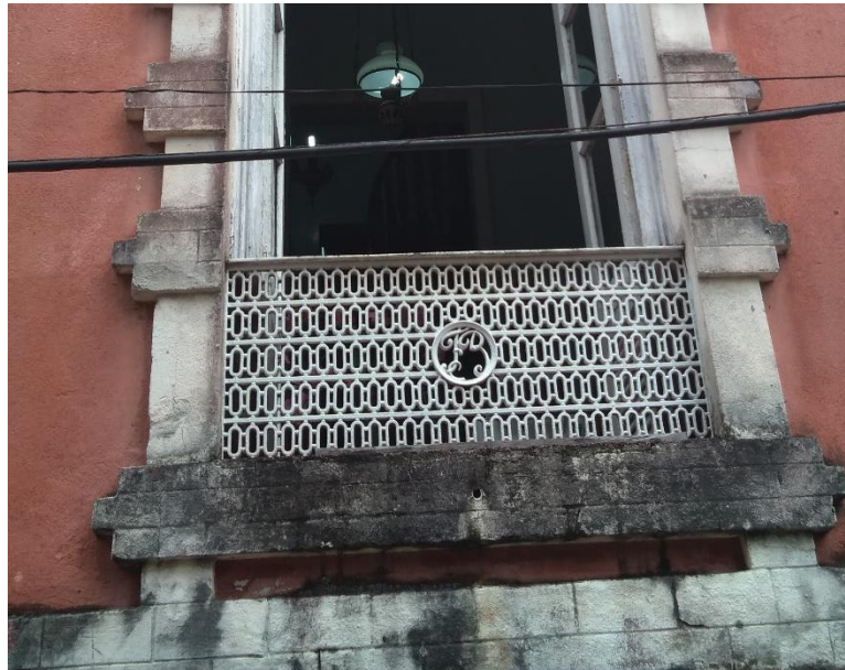
Figura 44: Parapeitos em ferro fundido da fachada da Casa 78
