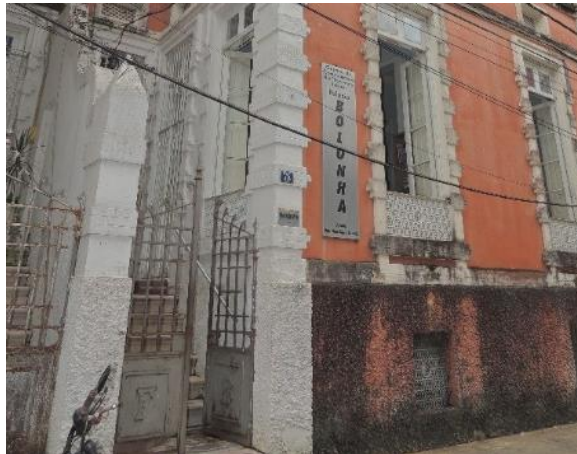
Figura 14: Acesso Principal do Palácio Bolonha
