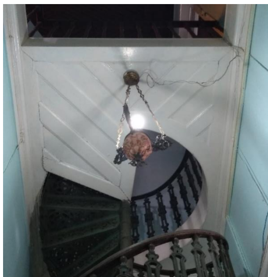
Figura 59: Forro do Hall da Escada
