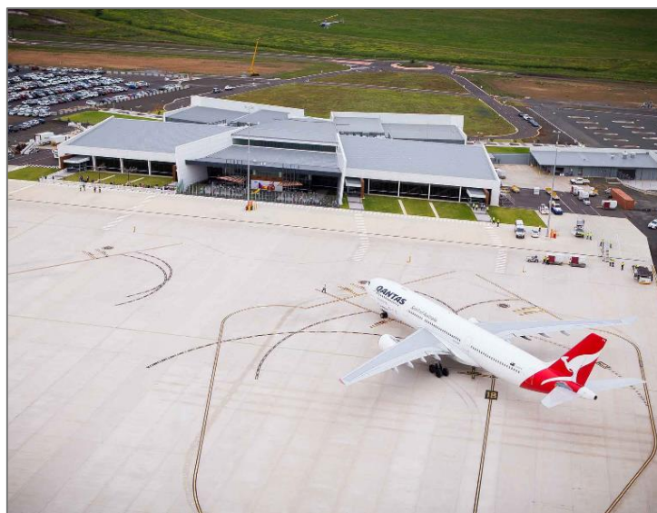
Figura 4 — aplicação do geopolímero em Brisbane West Wellcamp Airport
