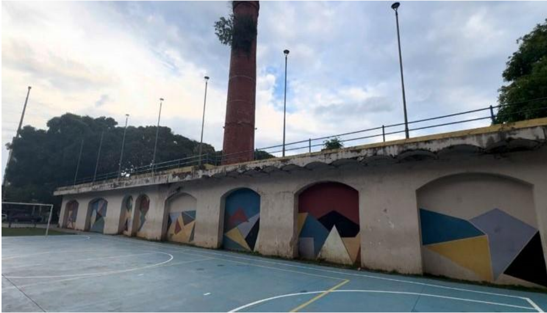
Figura 19: Fachada Posterior após revitalização- Prédio Forno Crematório
