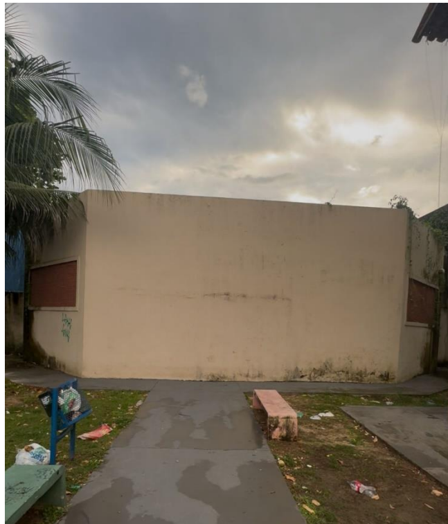
Figura 10: Fachada Posterior – Prédio de apoio à Escola Circo
