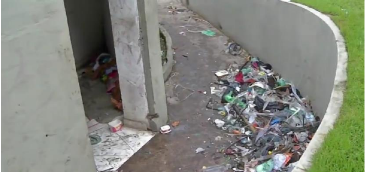
Figura 14: Acúculo de Lixo nas instalações da praça antes da revitalização de 2024
