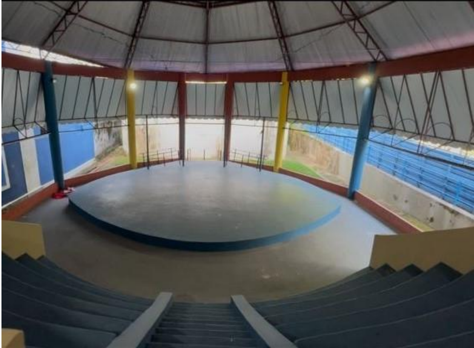
Figura 09: Estrutura Arquibancada Corberta - Escola Circo Mano da Silva
