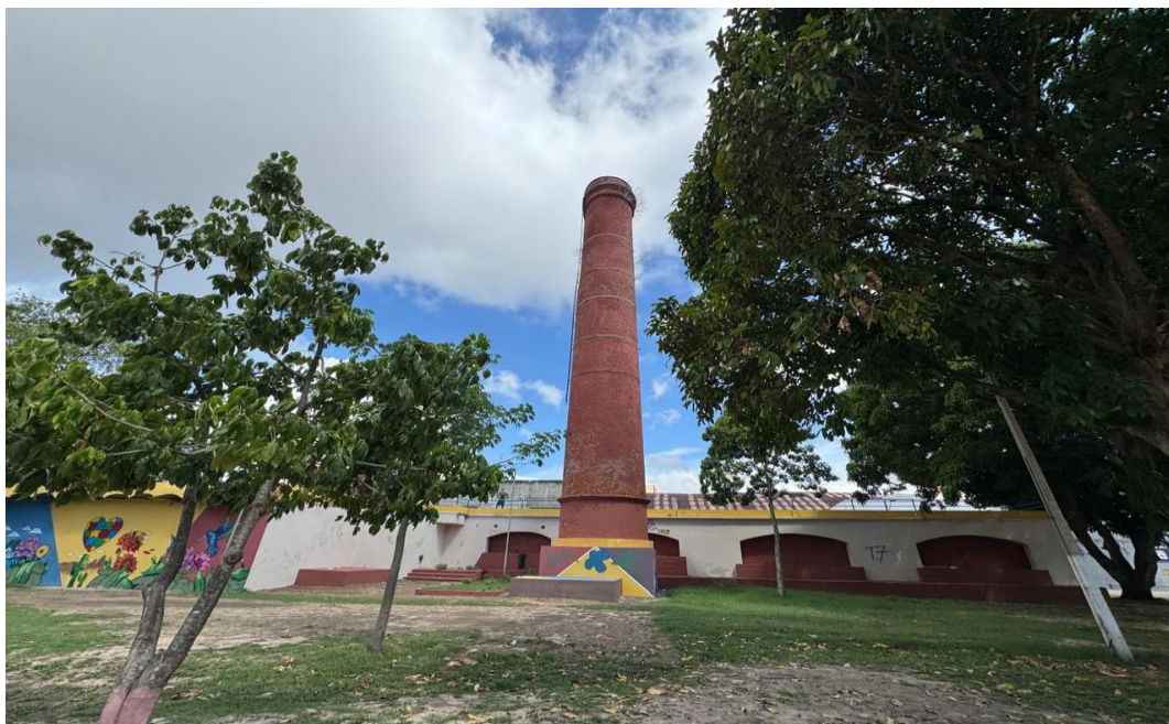
Figura 18: Fachada Frontal Prédio do Forno após revitalização de 2024
