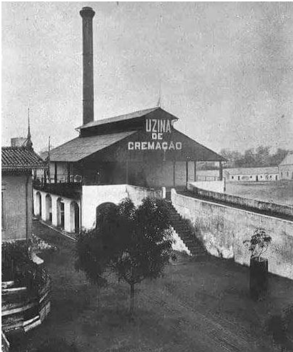
Figura 03: Edifício do Forno Crematório
