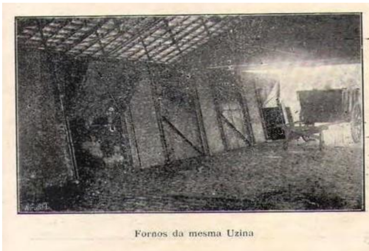
Figura 04: Estrutura dos Fornos no Primeiro pavimento
