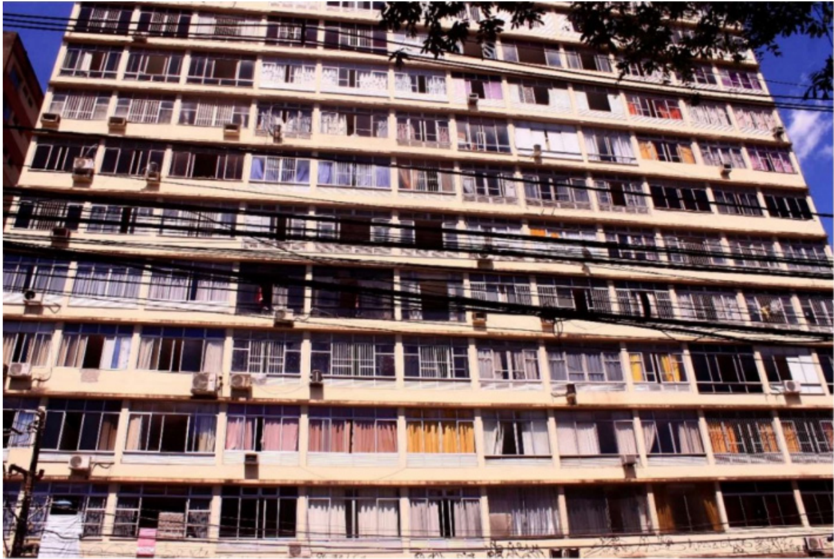
Figura 1 Fotografia da fachada do Edifício Banna, uma das construções de Alcyr Meira Fonte: Rebeca Dias, 2019 (publicação autorizada pela autora)
