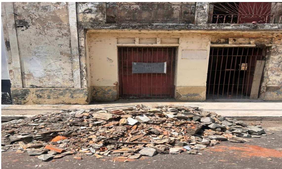
Figura 2: Resíduos de Construção e Demolição – Cametá-Pa
