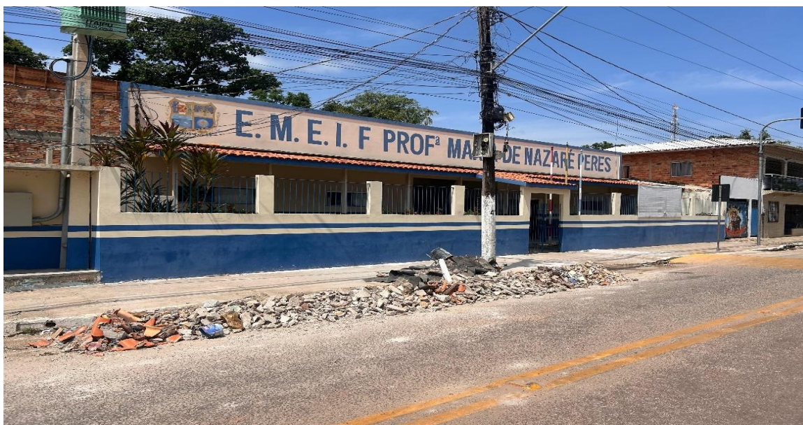
Figura 3: Resíduos de Construção Civil e Demolição advindas de Obras Públicas de Cametá-Pa.
