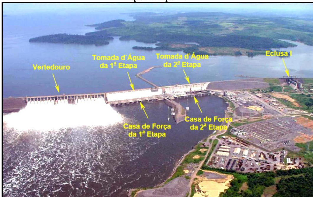
Figura 9 - Vista aérea do barramento do Rio Tocantins, destacando as principais estruturas de concreto que o compõem.
