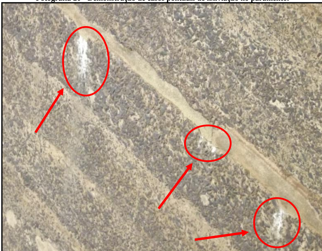
Fotografia 20 - Demonstração de casos pontuais de lixiviação no paramento.
