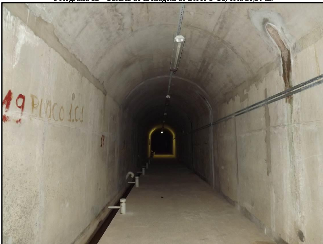
Fotografia 12 - Galeria de drenagem do Bloco 1-C1, cota 26,50 m.
