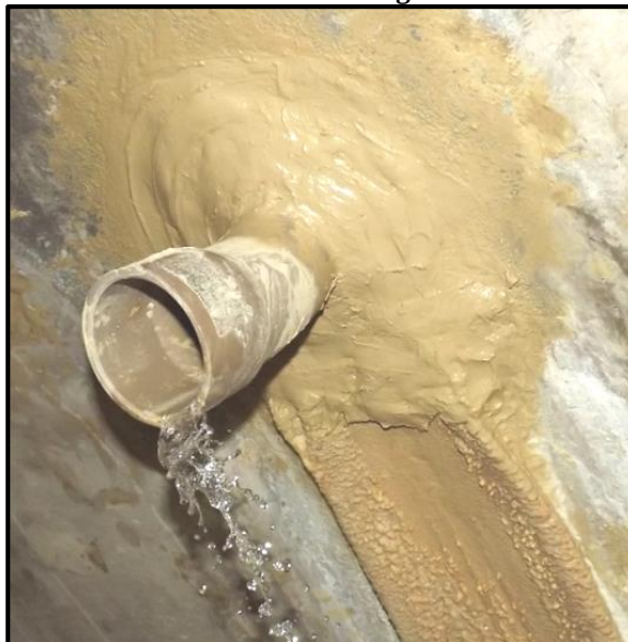
Fotografia 23 - Dreno 4, após finalizada a adaptação com conexão de PVC para direcionamento do escoamento de água.
