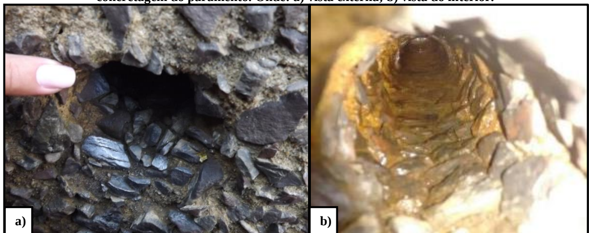
Fotografia 19 – Orifício de aproximadamente 10 mm de diâmetro encontrado próximo ao enrocamento, provavelmente causado pela retirada, sem reparo, de um dos fixadores das fôrmas utilizadas durante a concretagem do paramento. Onde: a) vista externa; b) vista do interior.
