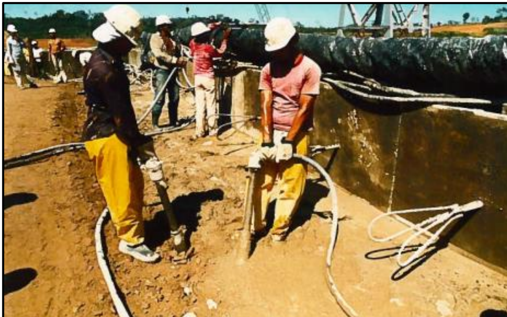
Fotografia 5 - “Costura” do contato CCV (à direita) x CCR (à esquerda), utilizando vibradores mecânicos.
