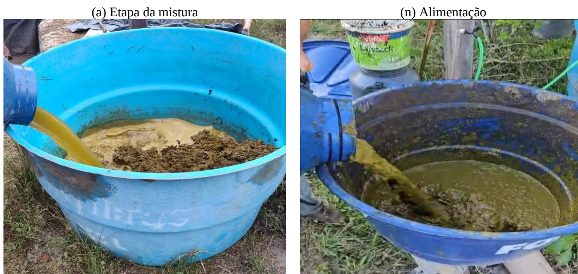
Figura 22 – Primeira alimentação do biodigestor tubular após a conclusão da implantação
