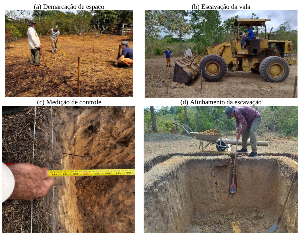
Figura 20 – Etapas de implantação do biodigestor tubular na propriedade rural
