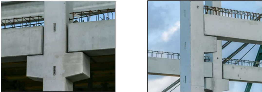
Figura 1.1 - Utilização de consolos de concreto armado
