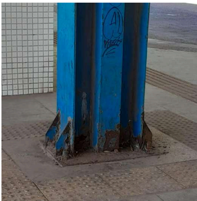
Imagem 45 - Base pilar existente
