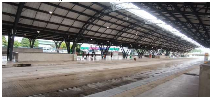
Imagem 19 - Estrutura geral do terminal
