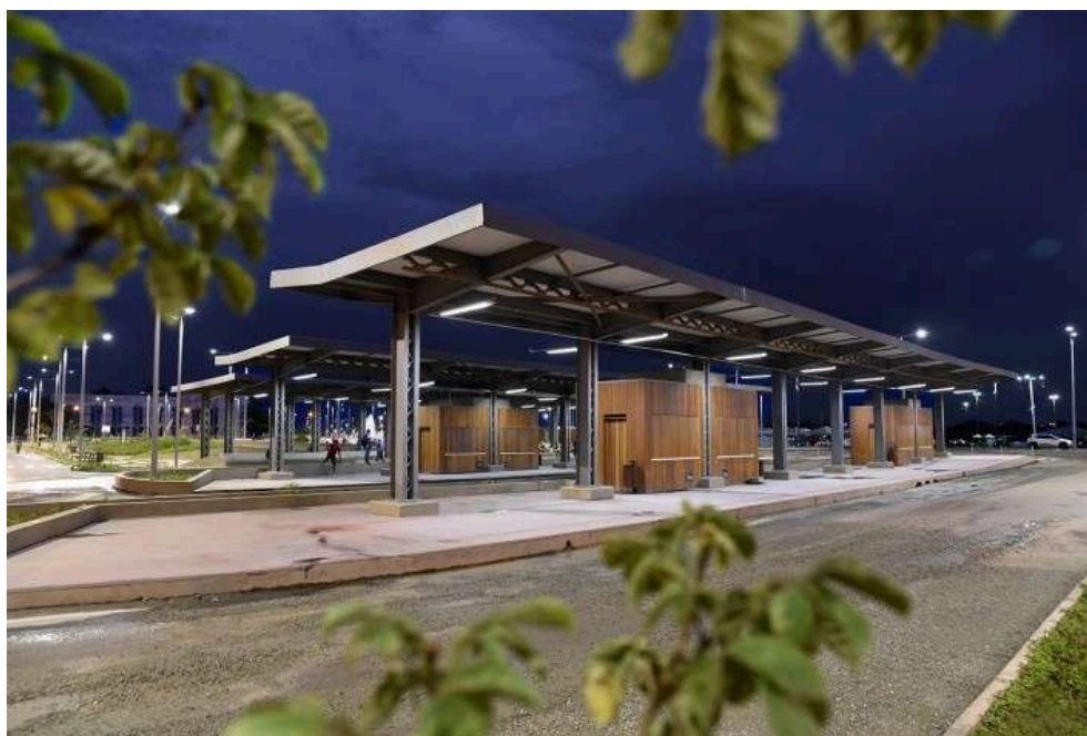
Imagem 25- Vista a noite da nova área comercial do terminal
