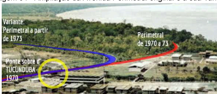
Imagem 04 - Ampliação da Avenida Perimetral original e a sua Variante
