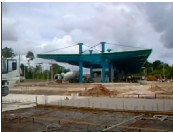
Imagem 09 - Processo de construção do Terminal Urbano da UFPA
