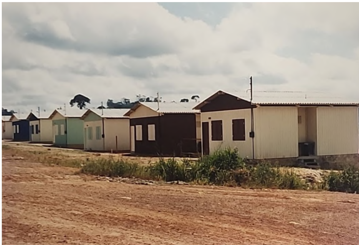
Figura 11 - Casas de Novo Repartimento durante a construção (1989).
