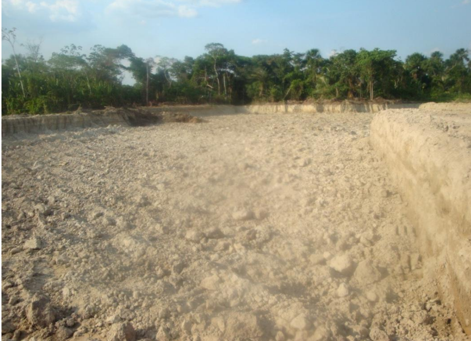
Figura 2: Decapeamento vegetal e desmatamento.
