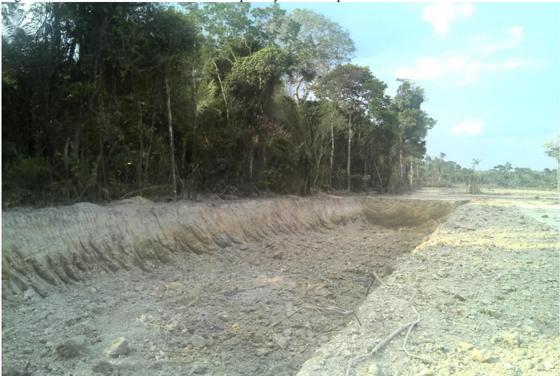
Figura 7: Cava No Tamanho Padrão Para Implantação De Tanques Para Piscicultura
