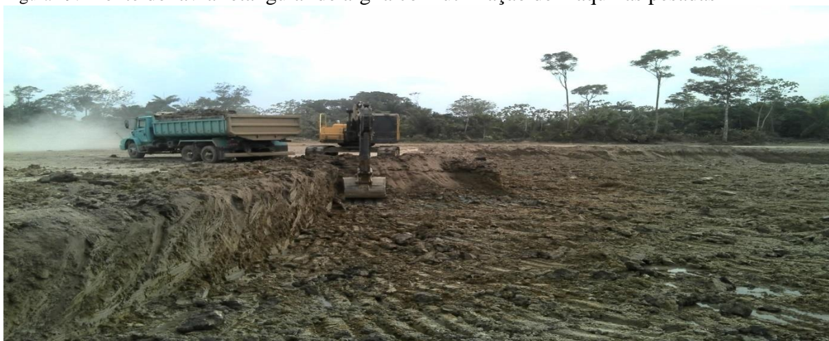
Figura 29: Frente de lavra retangular de argila com utilização de maquinas pesadas
