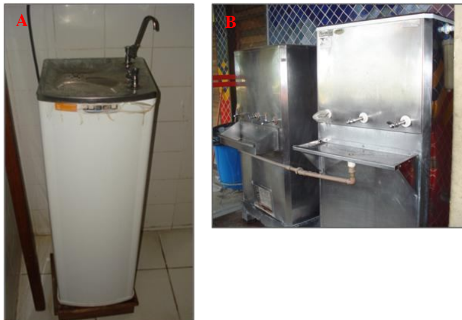
Figura 11: A) Bebedouro de classificação tipo 1 e/ou 2 da Biblioteca Central (BCm) e B) Bebedouro do RU classificado em tipo 1 e/ou 3, em uso. Localizado na Cidade Universitária da UFPA (Março/2013).
