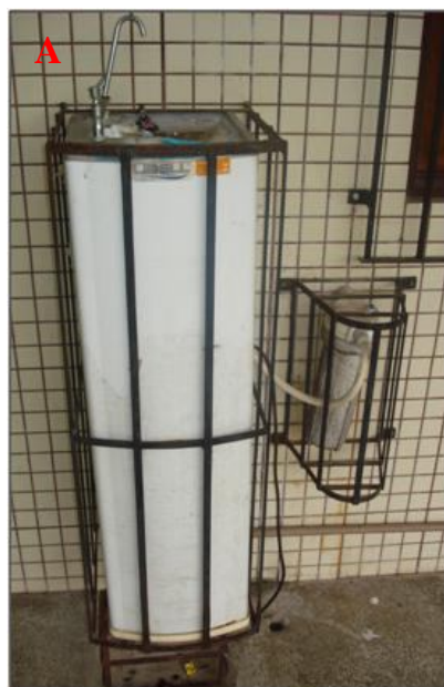
Figura 13: Bebedouro do Bloco O, em uso. Na Figura A, detalhe para o filtro com prazo de validade possivelmente vencido. E em B, detalhe dos resíduos sólidos despejados pelo usuário. Localizado na Cidade Universitária da UFPA (Março/2013).
