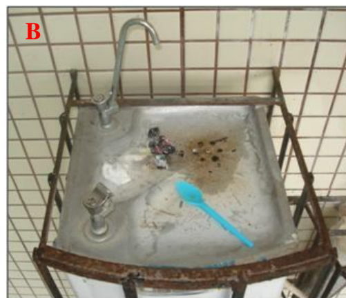
Figura 13: Bebedouro do Bloco O, em uso. Na Figura A, detalhe para o filtro com prazo de validade possivelmente vencido. E em B, detalhe dos resíduos sólidos despejados pelo usuário. Localizado na Cidade Universitária da UFPA (Março/2013).
