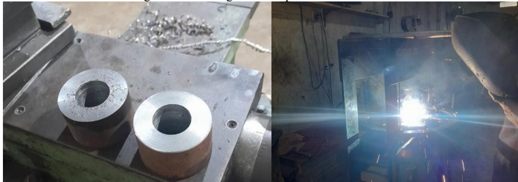
Figura 53 – Soldagem da chapa e eixo central
