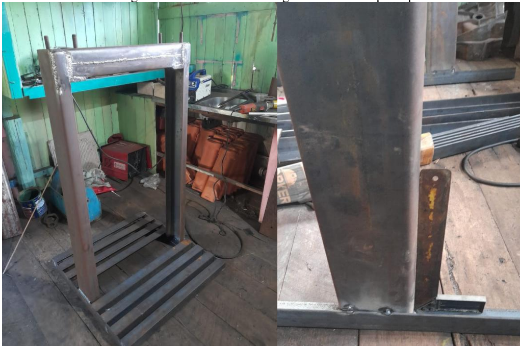
Figura 49 – Processo de soldagem da estrutura principal
