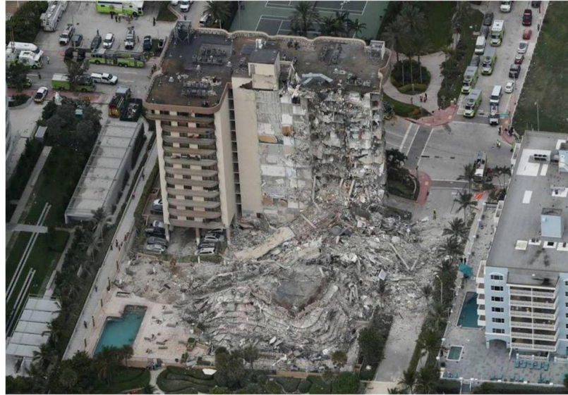
Figura 2 – Colapso parcial do edifício Champlain Towers South
