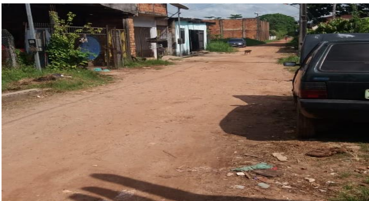
Figura 14 – Rua sem pavimentação
