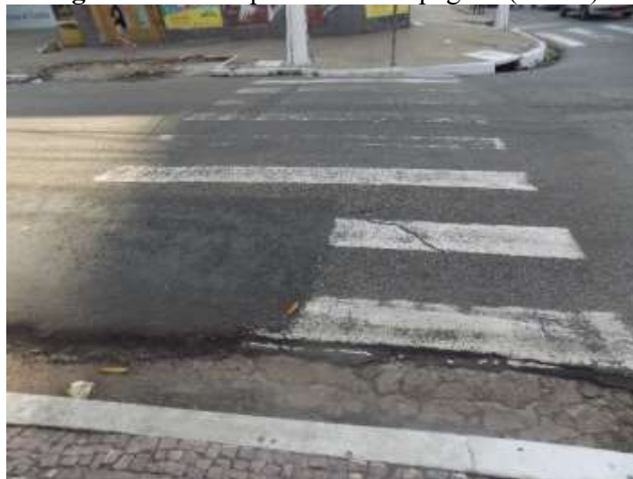
Figura 4.9: LRE parcialmente apagada (CS-08)
