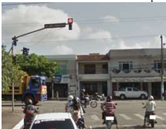
Figura 4.12: GF secundário instalado em coluna simples junto ao GF-03
