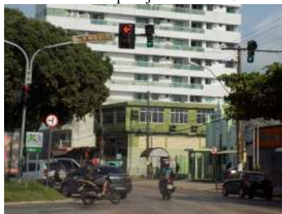
Figura 4.11: GF secundário instalado em coluna simples junto ao GF-01
