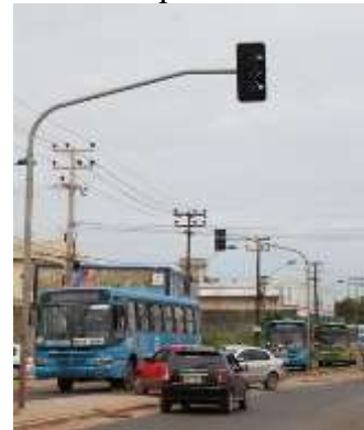
Figura 2.13: Anteparo instalado sem orla
