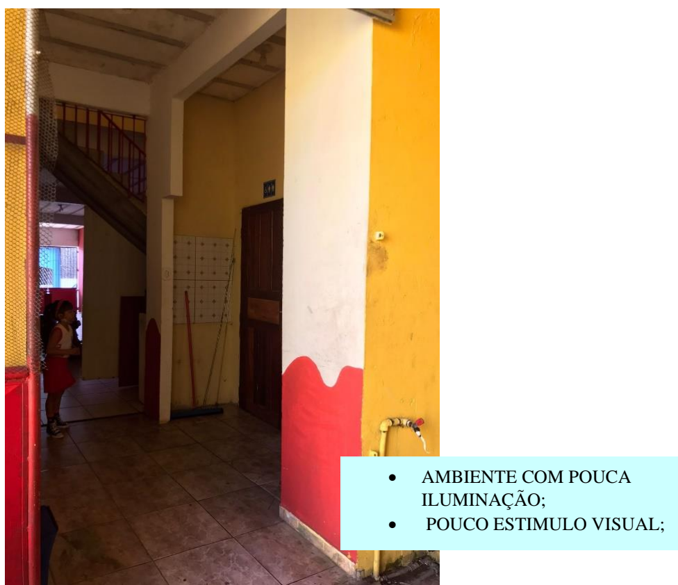
Figura 23 - Acesso aos banheiros da escola.
