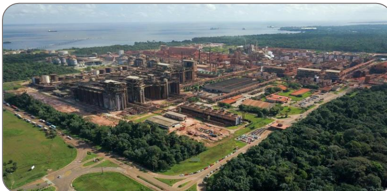
Figura 1 – Vista da refinaria de alumina na cidade de Barcarena-PA
