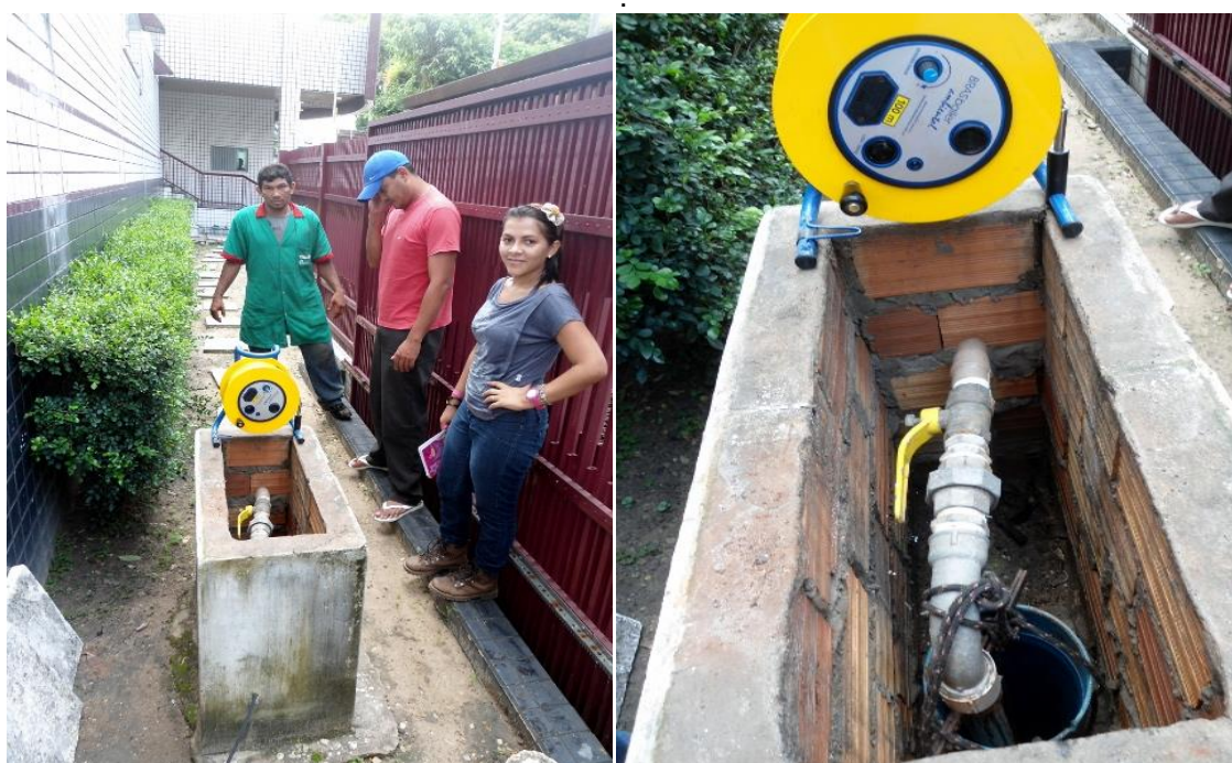
Figura 16: Poço tubular raso no prédio Palais Lar Rochele
