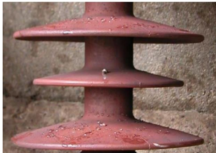
Figura 2.7 – Presença de camada de poluição na saia do isolador
