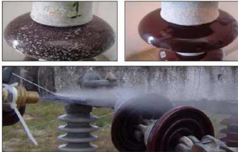
Figura 2.4 – processo de limpeza em isoladores de porcelana
