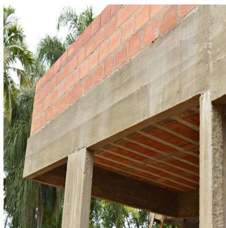
Figura 1.3: Vigas de concreto armado
