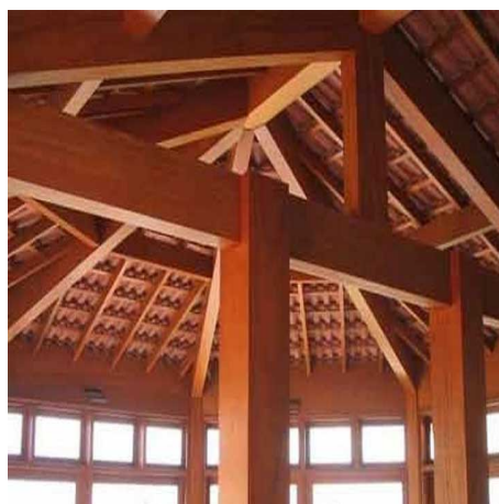
Figura 1.4: Vigas de madeira
