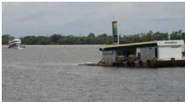
Figura 44- Balsa de abastecimento no meio do rio , em frente à cidade de Oriximiná
