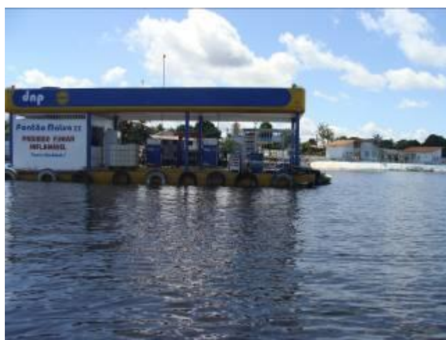
Figura 46 -Posto Fluvial de Terra Santa com capacidade de 45.000 litros de combustível,com casco simples em frente a outra cidade paraense.
