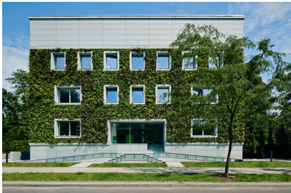
Figura 10: Fachada frontal da Sede da Fundação para Ciência Polonesa
