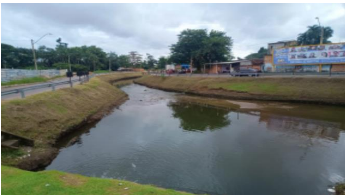
Figura 4 – Canal do Rio Maguari-Açú, no bairro do Maguari.
